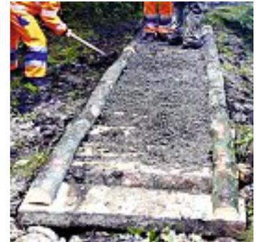
Abb. 18 Bedecken des Prügelwegs mit Bodenmaterial und Schotter
