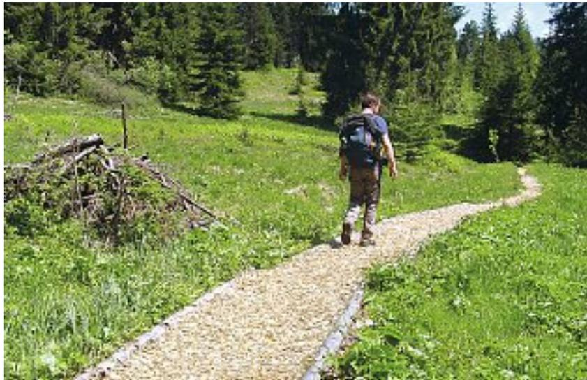
Abb. 19 Weg mit Foundationsschicht direkt auf dem gewachsenen Terrain
