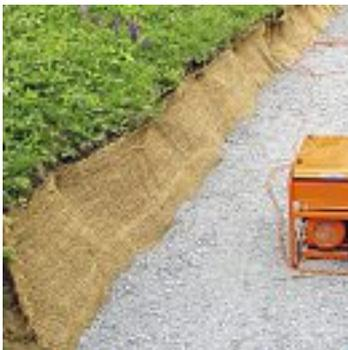
Abb. 76 Bahnen aus Jute schützen die Böschung während der Bauarbeiten vor Erosion.
