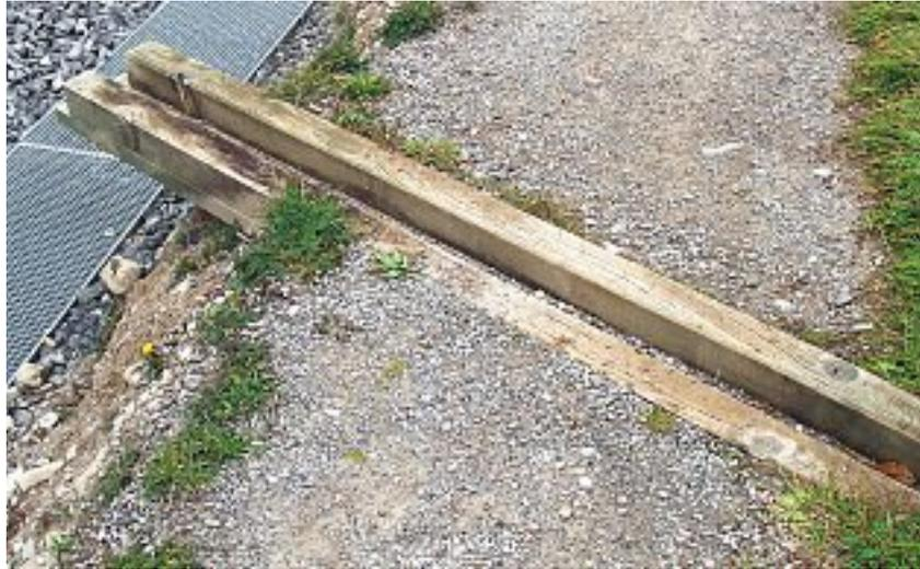
Von zentraler Bedeutung sind die richtige Platzierung und der regelmäßige Unterhalt der Querabschläge. Damit das anfallende Wasser kontrolliert weggeführt wird, müssen Entwässerungen oberhalb von Wegabschnitten in Falllinien, Kunstbauten (Treppen, Randabschlüsse, Stützmauern) sowie oberhalb der Wendepunkte angelegt werden (siehe auch Abschnitt 4.2).
