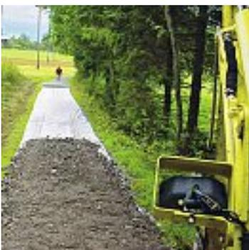
Abb. 20 Der Einbau der Foundationsschicht erfolgt vor Kopf.
