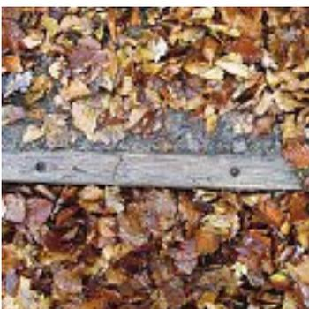
Abb. 56 Stufe mit Bohrloch für die Befestigung mit Armierungseisen
